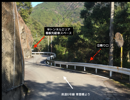
半トンネルエリア
