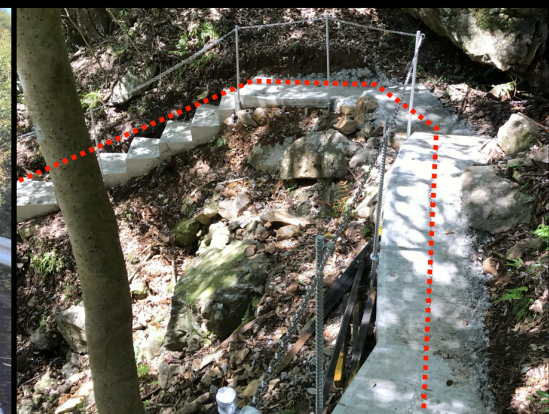
半トンネルエリアアプローチ
